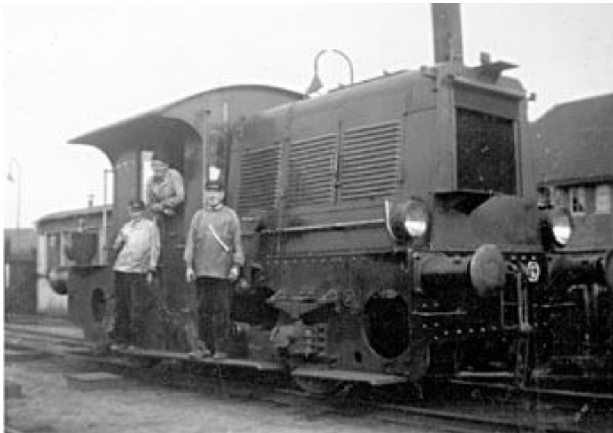
Een locomotor, kortweg Sik genoemd. Deze kleine locomotief werd gebruikt om te rangeren, wagons te verplaatsen.
